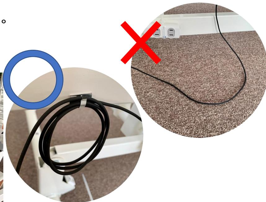
ケーブルは床に這わせず、⑦ケーブル固定支持具を用いてフレームに固定し、余剰部分は束ねて固定してください。
